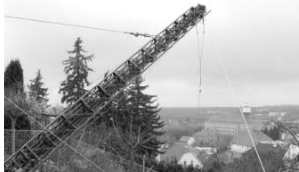
Obr. 1. Zdvihání stožáru s detailem kotvicího lana ve tvaru "Y"
