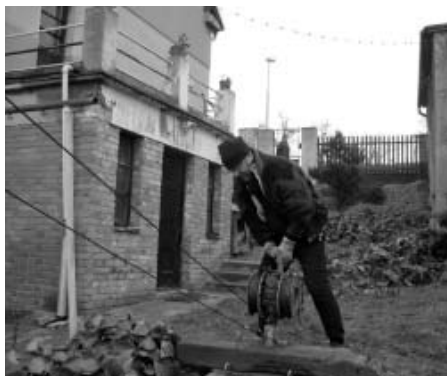
Obr. 2. Zdvíhání 14m stožáru pomocí navijáku
