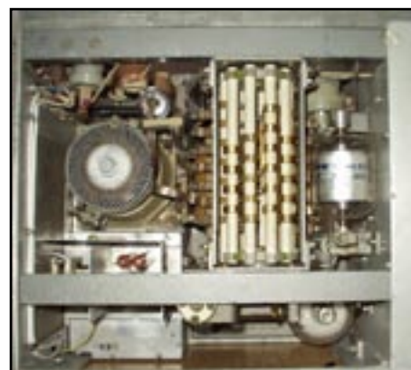
Obr. 10 Pohled na PA shora
