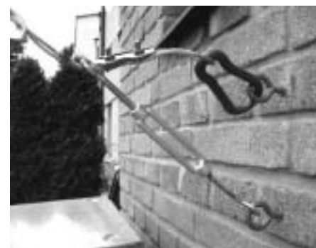
Obr. 10. Příklad kotvení napínačem jištěným karabinou
