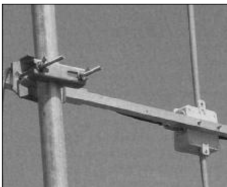
Obr. 2. Upevnění ráhna antény, umožňující posun pro dolaďování antény
