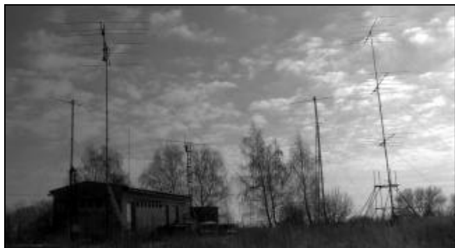
Antennní systém OK2RZ pro 10m: otočný stožár 6/6/6 el. OWA ve výškách 10/16/22 m, otočná 6 el. OWA @ 16 m, otočná 7 el. OWA na ráhnu 15 m @ 19 m, 2x fixní 6 el. OWA (směr USA a JA) @ 22 m, fixní HB9CV (směr jih) @ 17 m.
