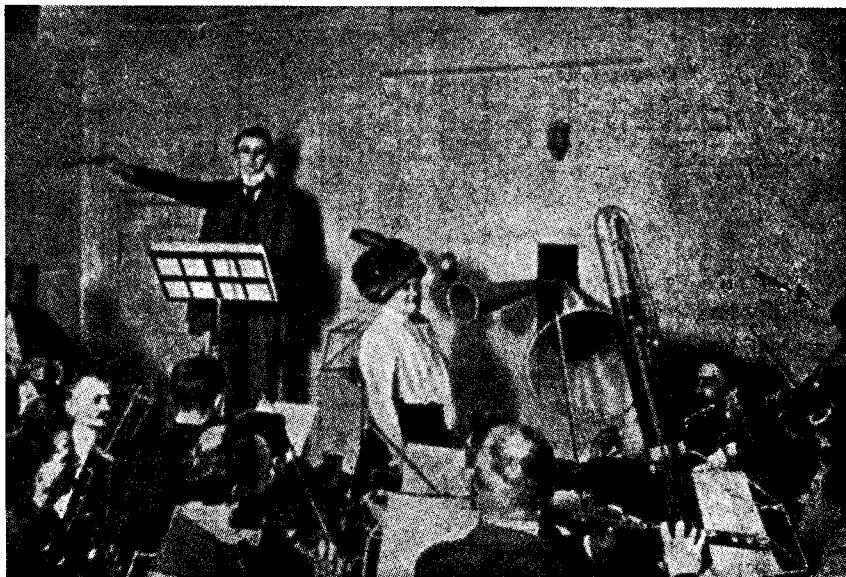
Nahrávání v dobách přímého akustického záznamu nebylo malým technickým problémem. Zpěvačka, kterou je známá koloraturka Frieda Hempelová, i orchestr jsou seskupeni těsně u trychtýřů, vedoucích k rycímu stroji v sousední místnosti, basové nástroje nejbližší, neboť na jejich rejstříky byl mechanický záznam nejméně citlivý.
