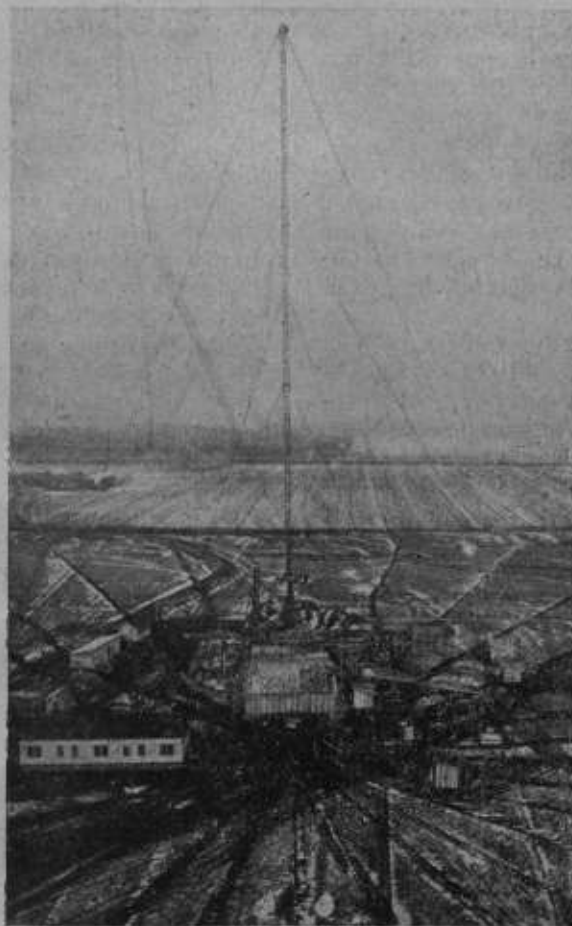
Obr. 1. Pohled s jednoho stožáru (s výšky 25 metrů) na druhý stožár, vysoký 150 m a na rozestavěnou budovu. Fotografie sejmuta v době, kdy byla kladena „protiváha“, síť to měděných kabelů v celkové délce 9000 m, uložených 40 cm hluboko pod povrchem země.
