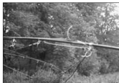
Obr. 13. Provedení pomocných ok.
