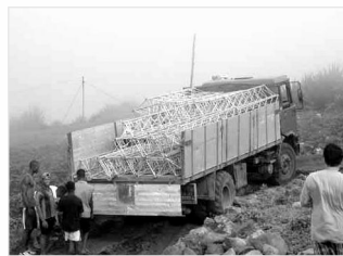
D4B - zbývá ještě hodně práce...
